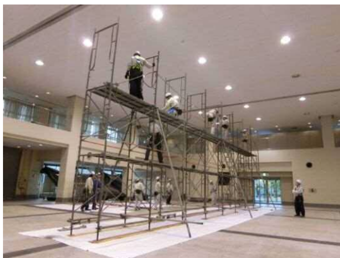
図3-10. 足場組立て（とび）の教育訓練
