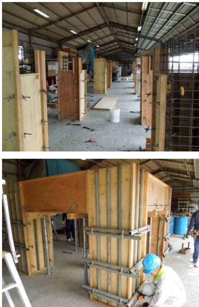
図4-4. 鉄筋・型枠の実習モデル
