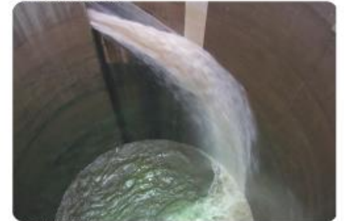
第5立坑（流入状況）
