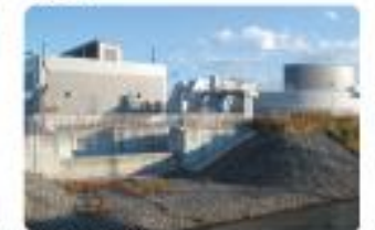
第4立坑（越流堤）
