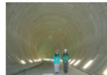
第4工区トンネル
