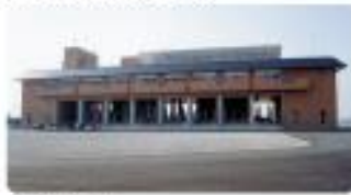
庄和排水機場
