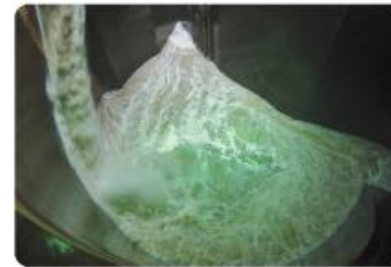
第3立坑（流入状況）
