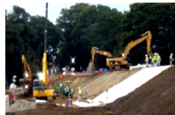
▲ 関東・東北豪雨の急復旧工事
