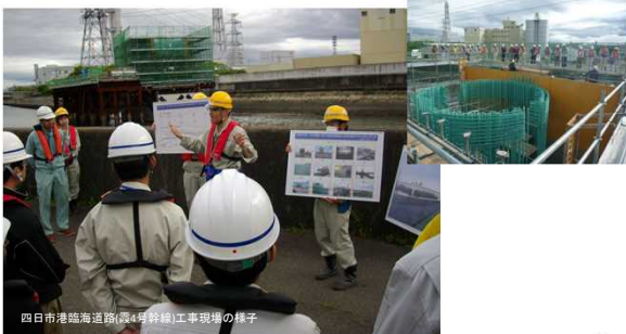
四日市港臨港道路(霞4号幹線)工事現場の様子
