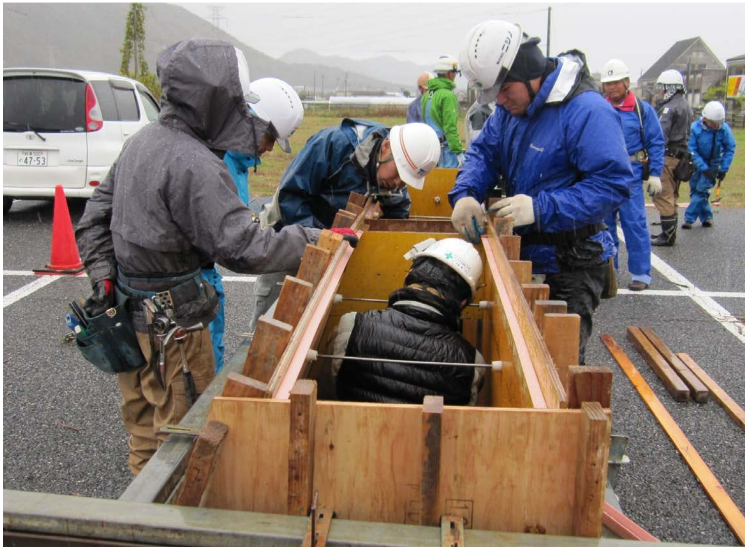
⑭重力擁壁_実習
