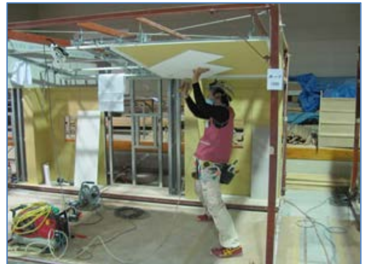
(内装工事の例)
