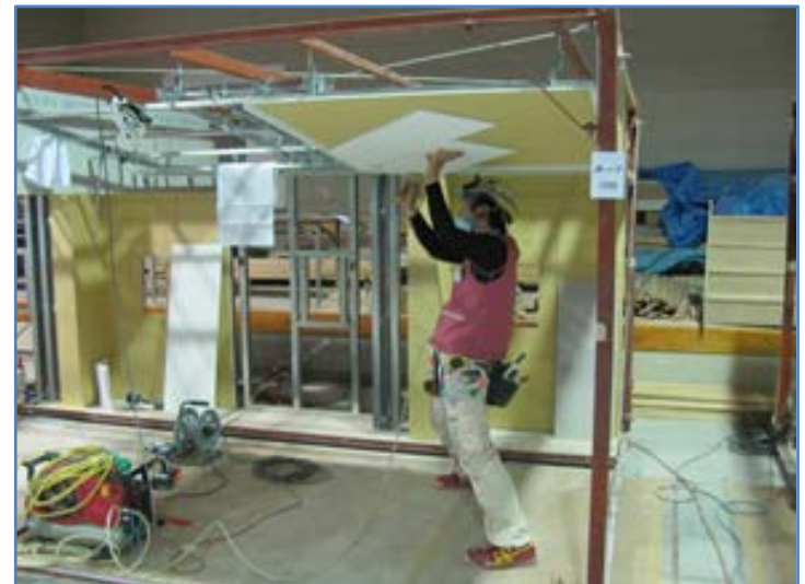
(内装工事の例)
