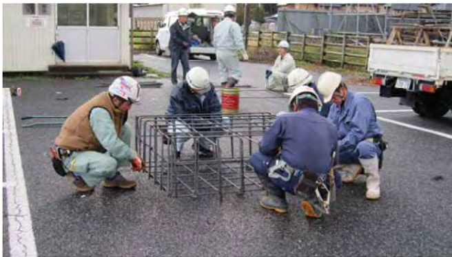
鉄筋組立実習
