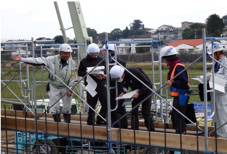
工事現場実習
