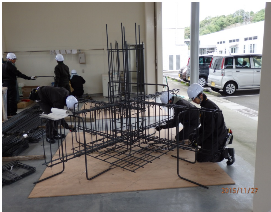
鉄筋組立実技研修
