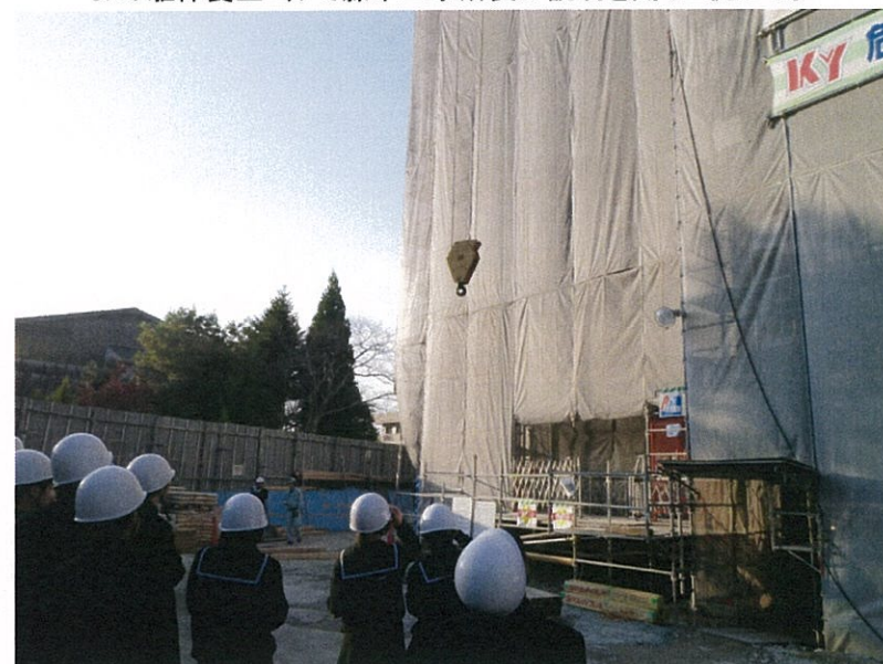
作業員のクレーン実演を見学する生徒達。
