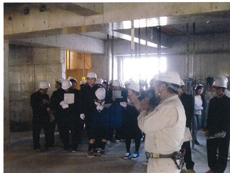
6Fの躯体養生エリアで藤本工事所長の説明を聞く生徒たち。
