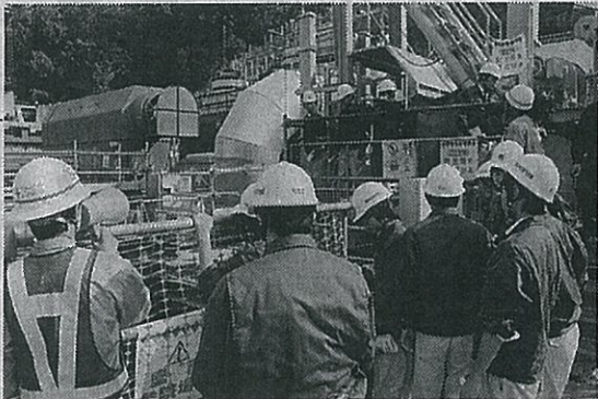
ゲート室部工事で立坑の内部を見学
