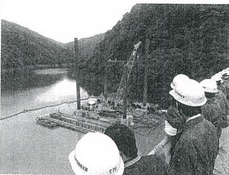
栈橋から水上の現場を見学
