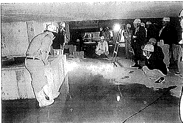
オフサイトセンターにおける免震装置の見学
