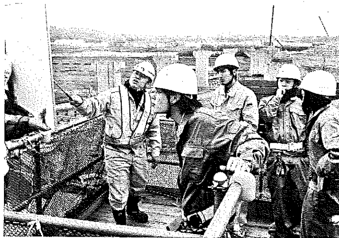
橋脚の上で熱心に説明を聞く生徒
