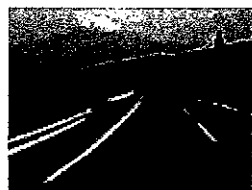
音響道路「メロディペーパー」 グルーピングを施し一定の速度で走行するとメロディが流れます。
