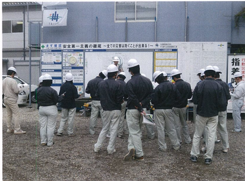
鹿島・山本所長からゲート室部工事の概要説明を受ける。
