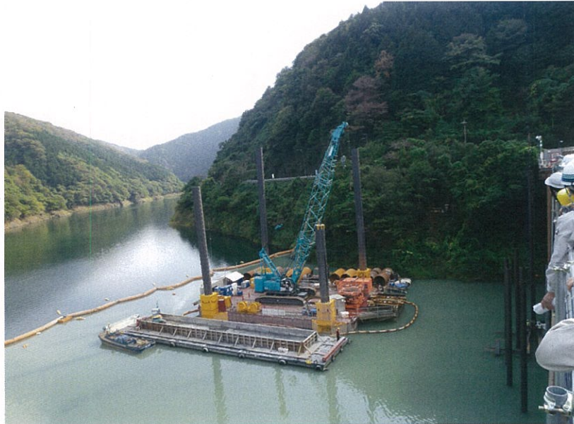
現場は川の上に浮かんでいる。資材・人は、上流の栈橋から船で来る。
