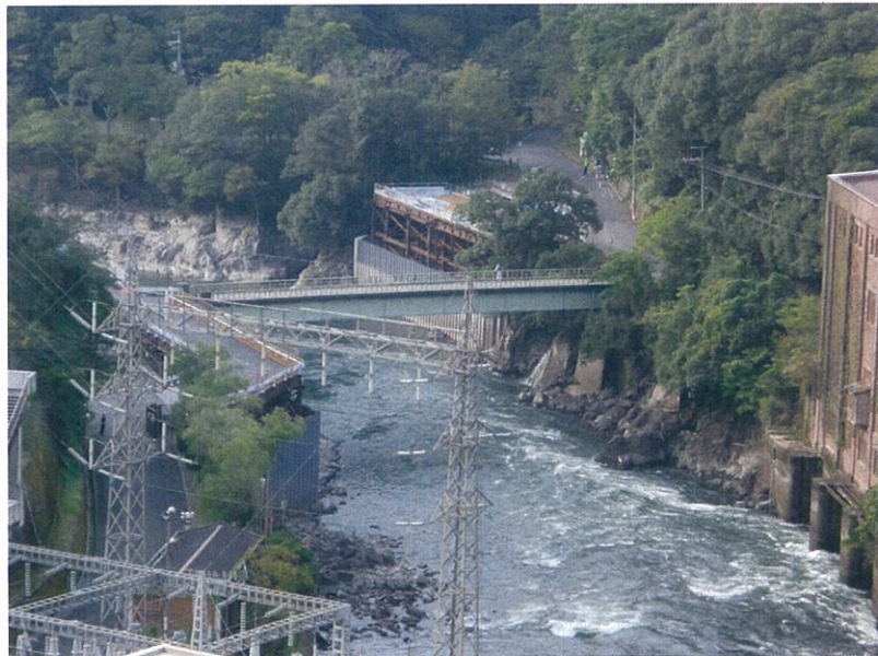
ダムより下流を望む。吐口部建設のため、白虹橋は架替られる。
