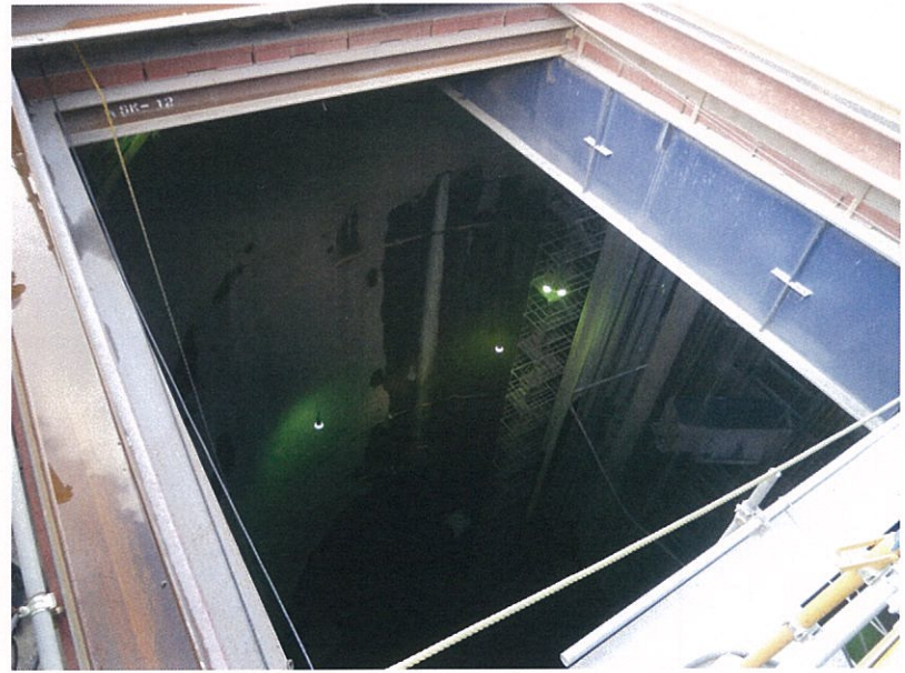
立坑内を覗く。トンネルは、発破もあるため立ち入れなかった。
