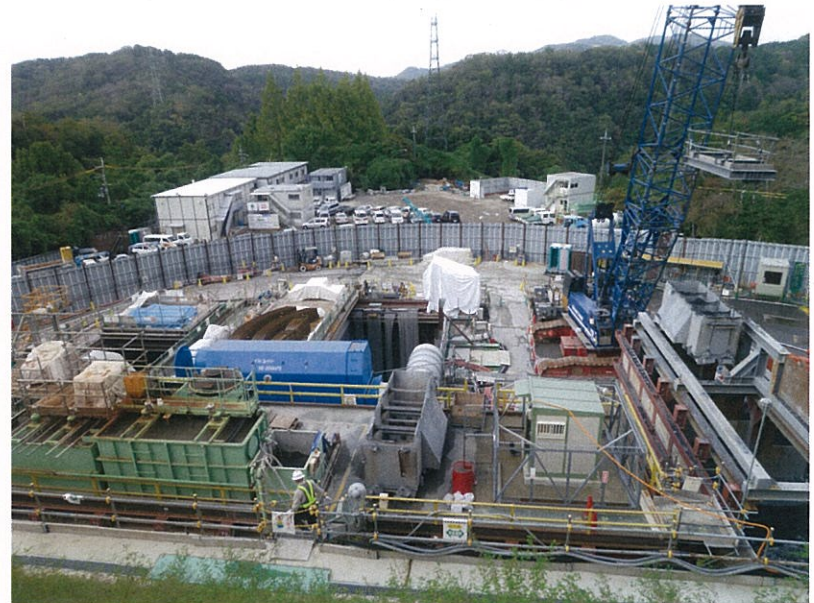
丘の上からゲート室部現場を一望する。
