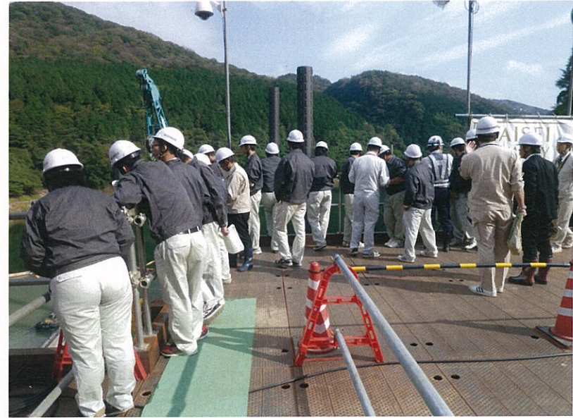
生徒たちは、食い入る様に下にある施工現場を見つめていた。
