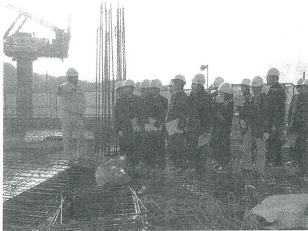
躯体工事エリアを見学
