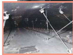
約2,300枚の天井板を取替え、さらに二重の安全対策として落下防止ワイヤを取り付けた。
