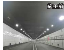
約2,300枚の天井板を取替え、さらに二重の安全対策として落下防止ワイヤを取り付けた。
