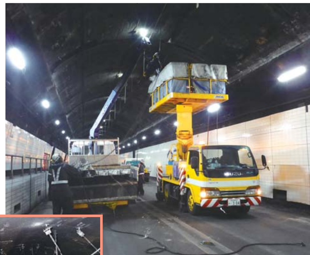
約2,300枚の天井板を取替え、さらに二重の安全対策として落下防止ワイヤを取り付けた。
