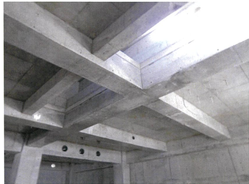
コンクリート打ちっぱなしの天井。これから電気や空調が整って行く。
