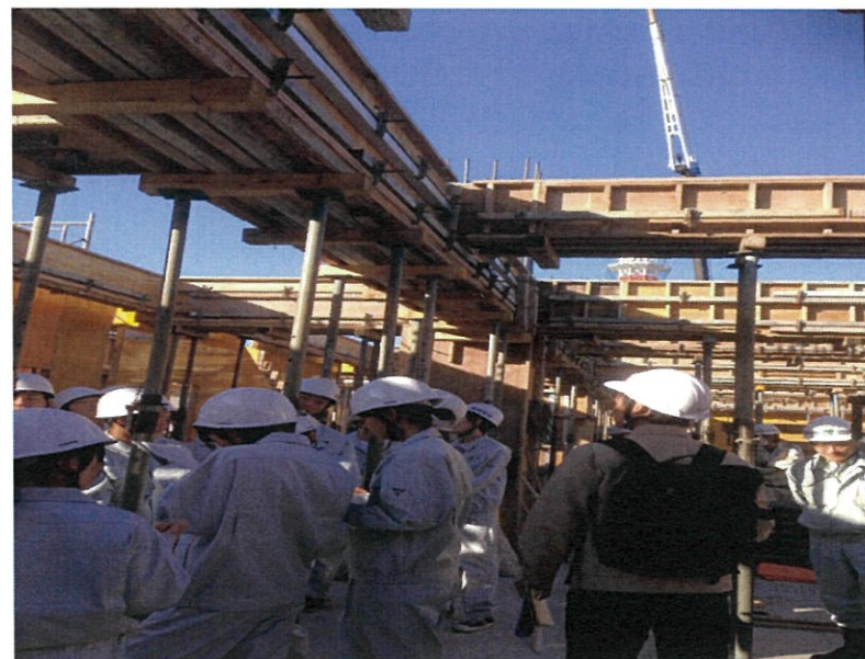
建設途中の4階部分を見学する。施工中の鉄筋を見せてもらった。
