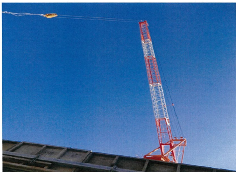
青空に天高くそびえるタワークレーン。見学中も休みなく資材運搬に徹す。
