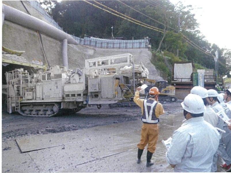
説明中、巨大なコンクリート吹付機がトンネルから姿を現した
