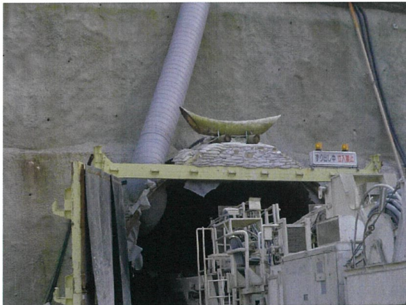
生徒が謎に思った木の正体は、工事の安全を祈願する「化粧木」であった
