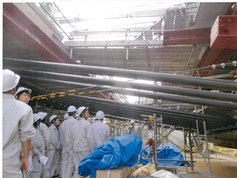
PC鋼材で出来たこの太い1次ケーブル上で橋体を構築する
