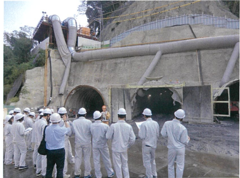
1つの抗口は小さいが、完成すれば23×26mの巨大トンネルになる
