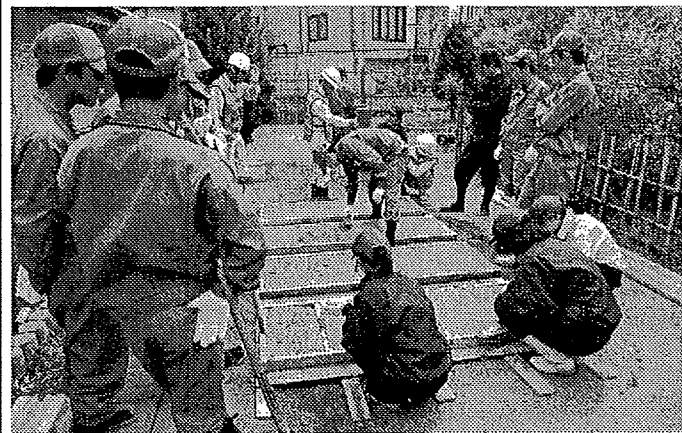
㊤土間コンクリート打ち ㊦平板づくり
