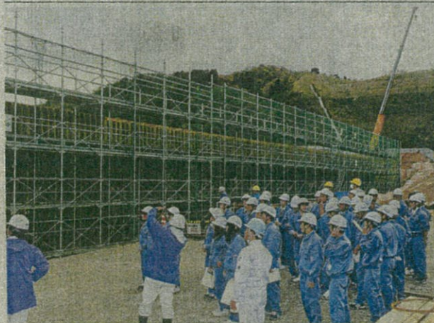
ヘルメットと作業着姿で高架橋の工事現場を見学する生徒たち＝10日、岩美町浦富
