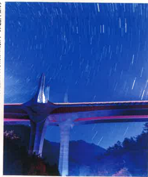
公益社団法人滋賀県建設産業界団体連合会長賞 「湖南アルプスを跨ぐ」 福田 尚人 [滋賀県] <滋賀県大津市 (近江大鳥橋)>
