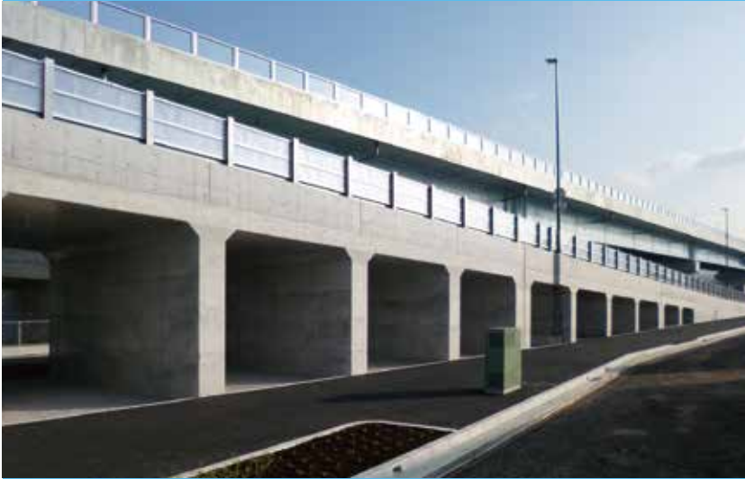
平成22年度 国道136号函南三島バイパス工事 〈 第30回静岡県建設業協会賞 土木部門 最優秀賞 〉
