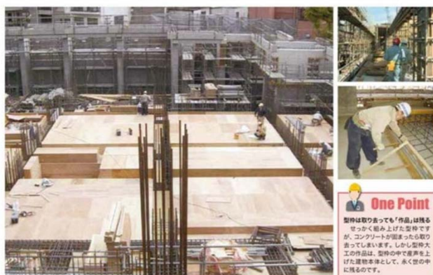
コンクリートを流し込むための型枠をつくる大工さんです。
