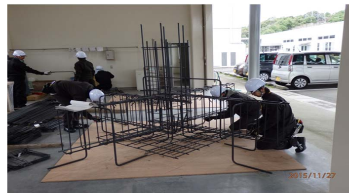
【緊急育成支援事業:鉄筋組立実技研修】
