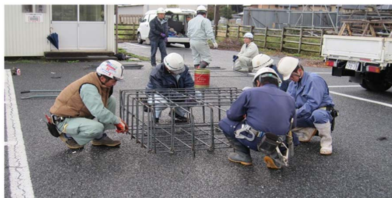
【鉄筋の多能工研修】
