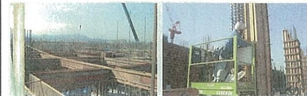
鉄筋コンクリートの建物は、まだ柔らかいコンクリートを建物の形の「枠」に流し込み、固まらせて作ります。
