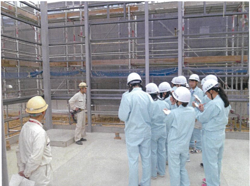
ボイラー棟の現場。骨組が概ね完成しており、工事は6割方完了している。
