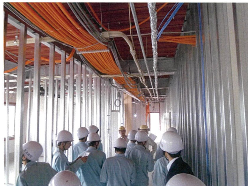
事務棟現場の中を行く。壁の骨格ともいえるアルミの柱がずらり。
