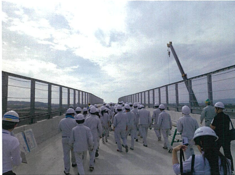
公道上への落下防止のため、分厚くなった防止柵が並ぶBランプ橋を歩く。
