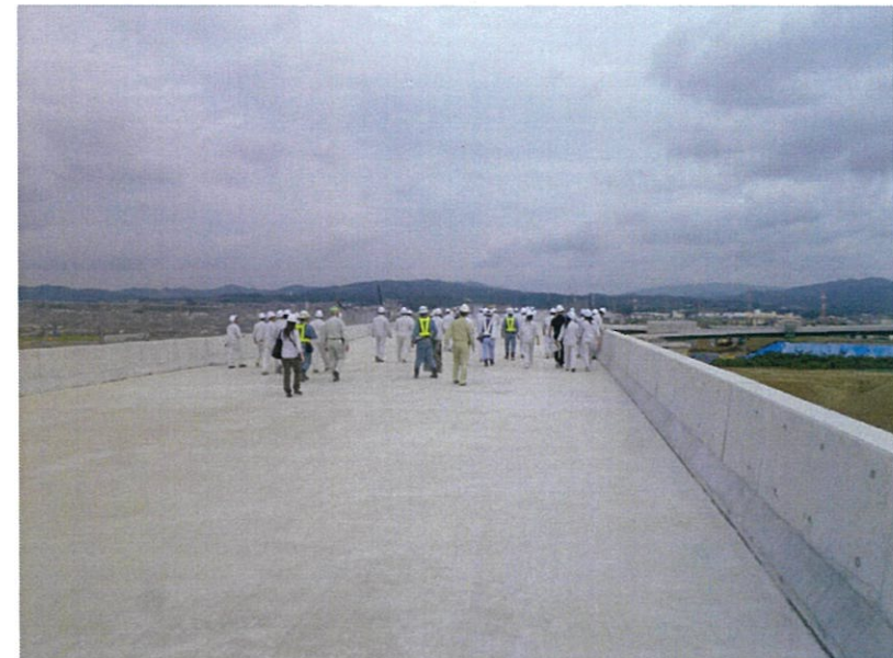
JCTは来年度共用予定。来年には立派な道路となり、この景色は見られなくなる。
