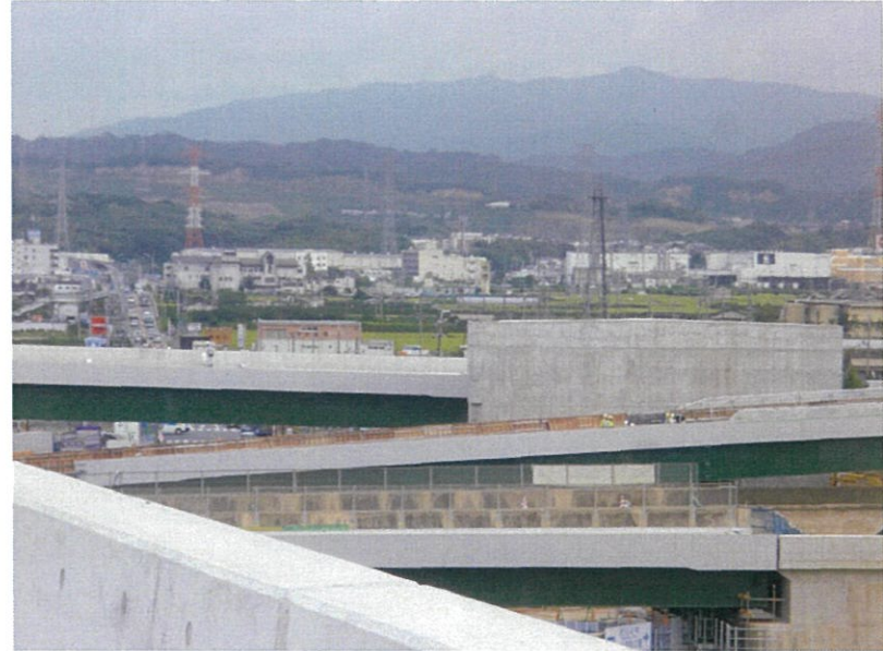
建設中の本線橋脚があった。道路は向かいの山肌を貫き、大津へ続く予定。
