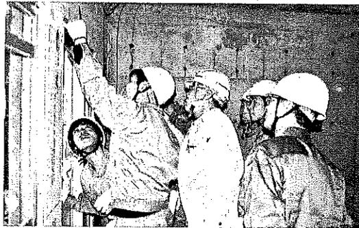
大阪府建設業懇話会は、大阪府菅瓜破西第4期高層住宅建て替え(第1・2工区)の現場見学会を開いた。西野田工科高校建築都市工学系建築システムの2年生約40人が参加し、内装工事の様子や鉄筋ガス圧接の実演などを見学した。写真。参加した生徒の一人は、「内装工事の完成までの過程を、順を追って見学できたので分かりやすかったです」と感想を話していた。
