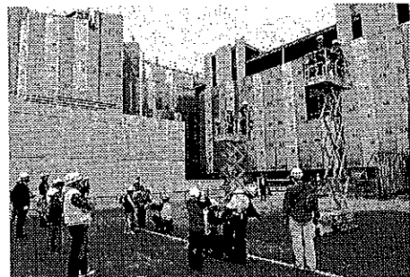
病院建設現場で高所作業車に乗車
