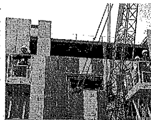
高所作業車に試乗しその作業を体感した
