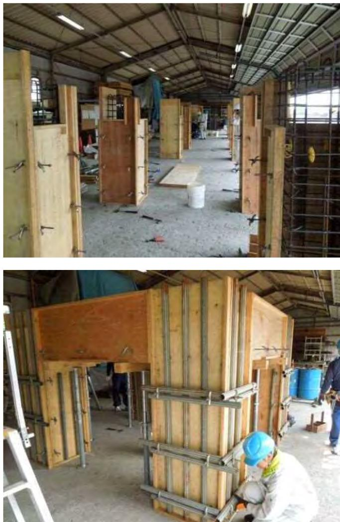
図4-4. 鉄筋・型枠の実習モデル
