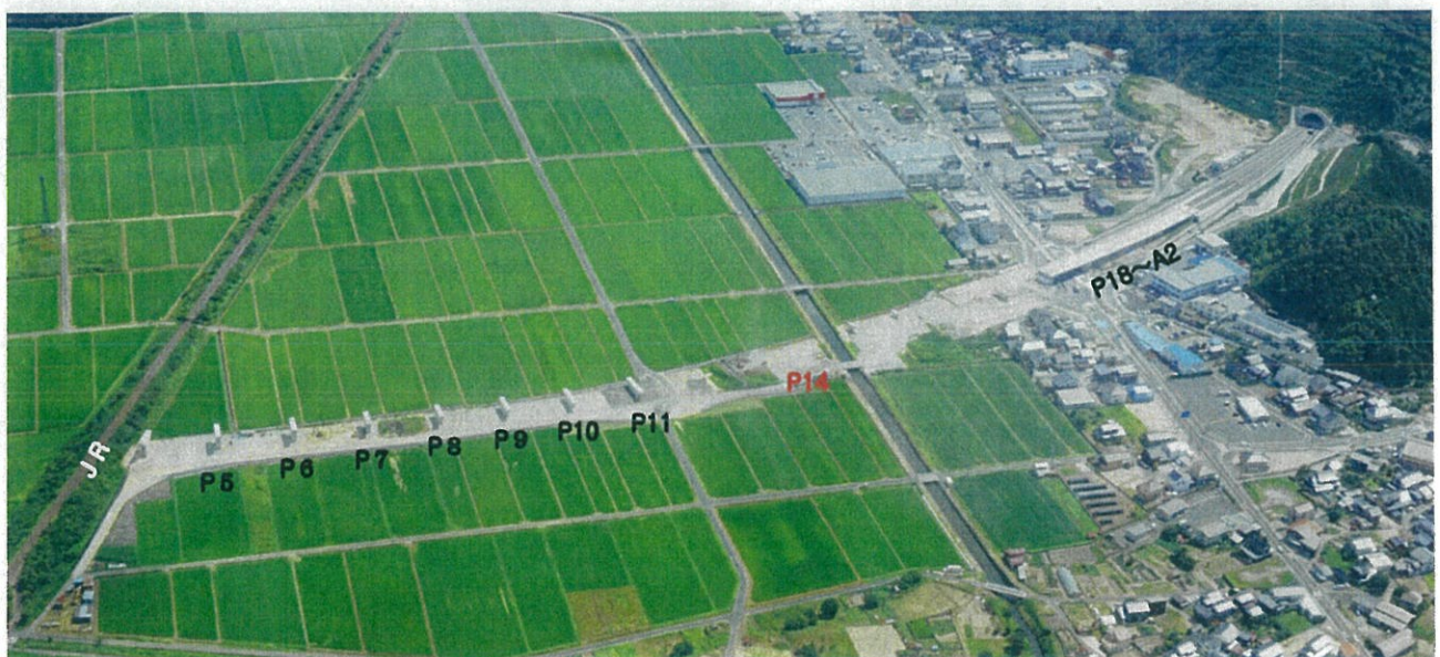
写真-4 浦富高架橋の上空写真（平成）29年8月撮影）
