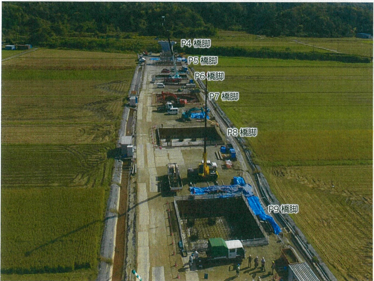
写真-5 ドローンによる上空からの撮影 (平成 28 年 10 月 20 日撮影)
