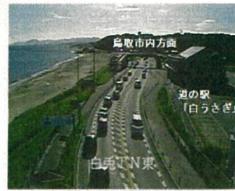
写真 国道9号白兔付近 渋滞状況(平日・朝) (鳥取市白兔地内 H25.8月撮影)
