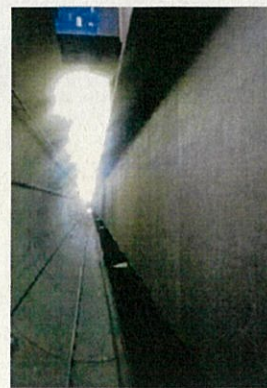
⑫ コンクリート舗装の完了 施工完了です。規定の強度が出るまで養生を行います。
