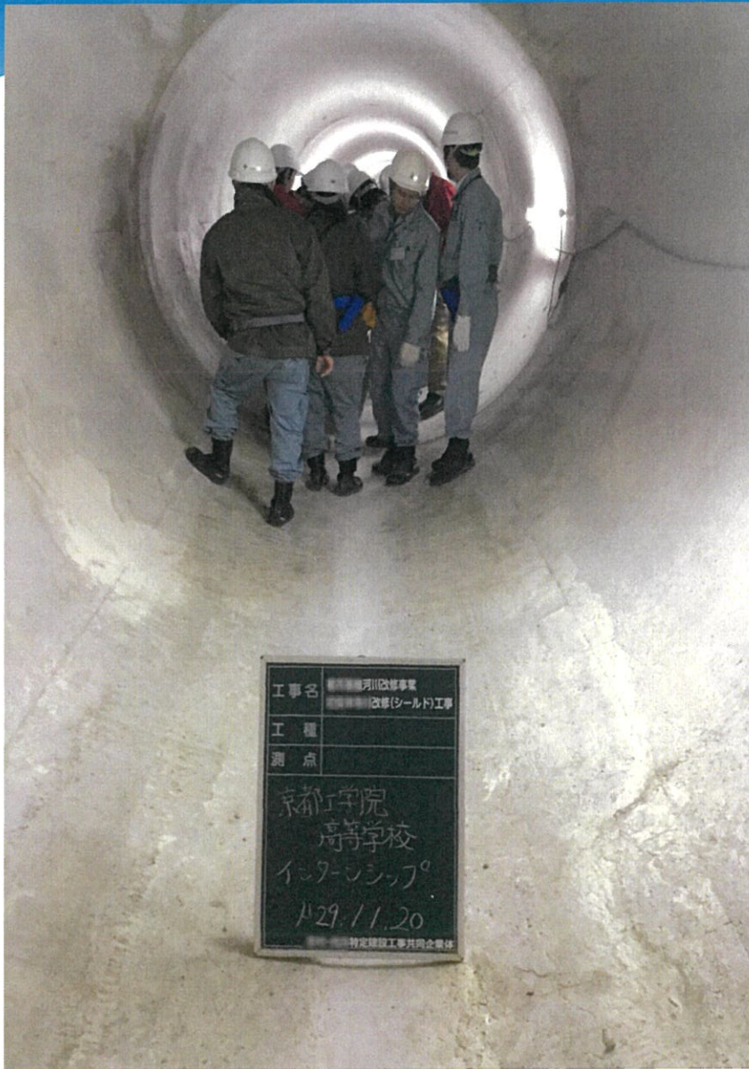
河川改修工事の一環で新設された地下トンネル現場で実習する生徒たち。
