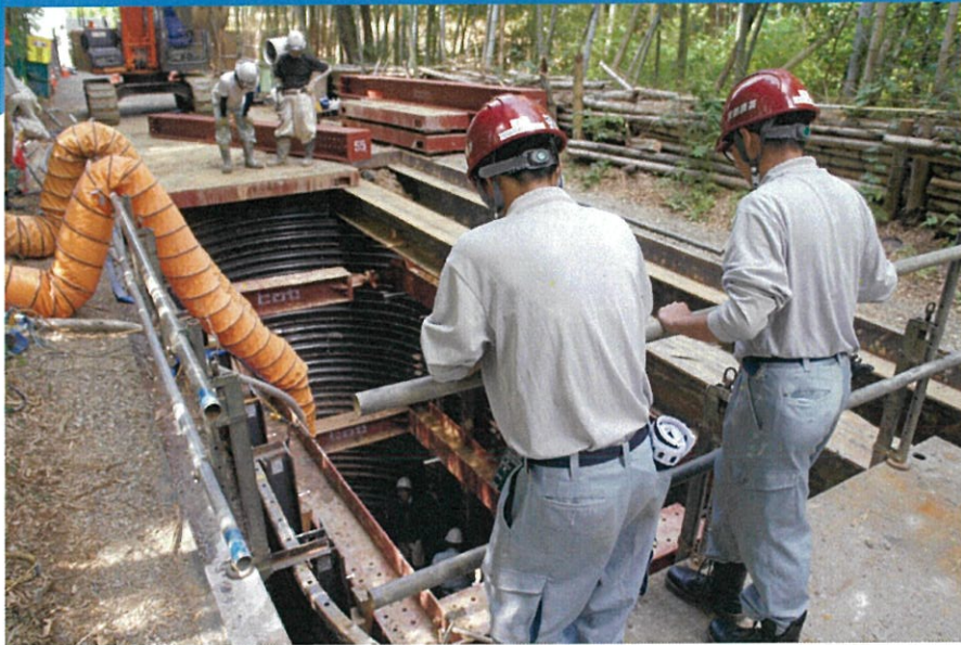
地下の作業現場をのぞきこむ。土木工事は、地上のみならず地下も舞台だ。
