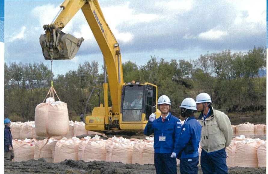
現場で意気込みを熱く語る実習生。背後では、土のう作りにショベルカーが稼働中。
