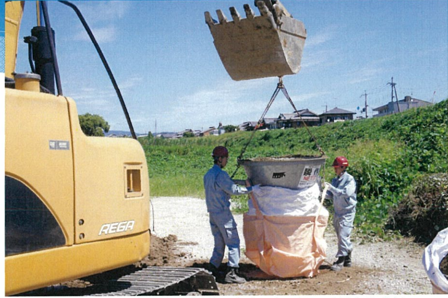
2人掛かりで土のう作り。作る数も多いため、チームワークは欠かせない。
