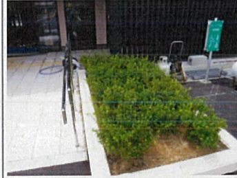
植栽工事 花壇 サツキアツシ植込み施工完了状況
