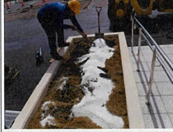
植栽工事 花壇 土壌改良剤、肥料施肥状況
