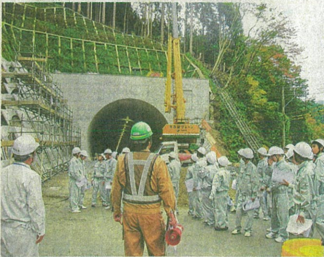
トンネル工事現場を見学する生徒たち
