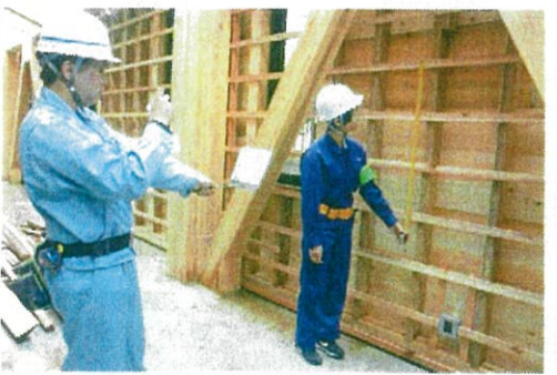
日南町体育館での現場実習
