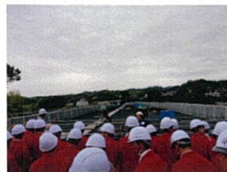
橋梁工事の最前線を見学
