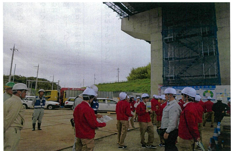
手前では、生徒の1人が工法や素材について、現場代理人の方に質問していた。
