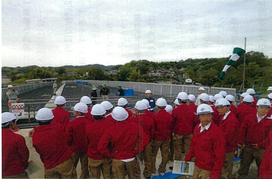
橋の上に上ると、今、まさに鉄筋工の作業中で、職人さんが打ち合わせていた。
