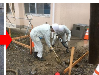
老朽化した集水枡を撤去、 透水性舗装の現場を溝堀
