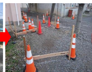
施工高が記載された丁張
