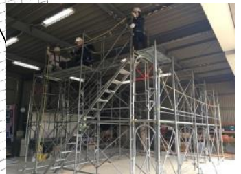
枠組足場組立
