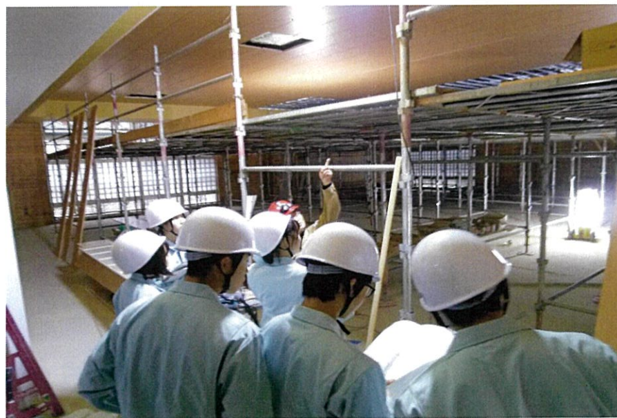
1F武道場の現場。和のスポーツを意識し、杉板の壁と杉桁天井を採用。
