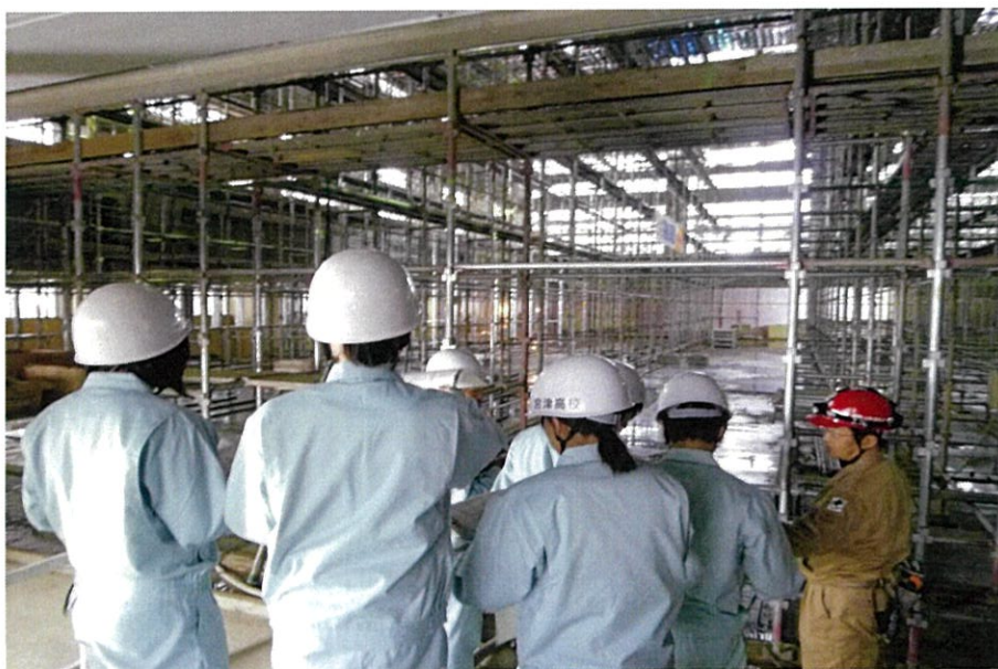
新設される体育館部分の現場。天井が高いため、たくさんの足場が建ち並ぶ。
