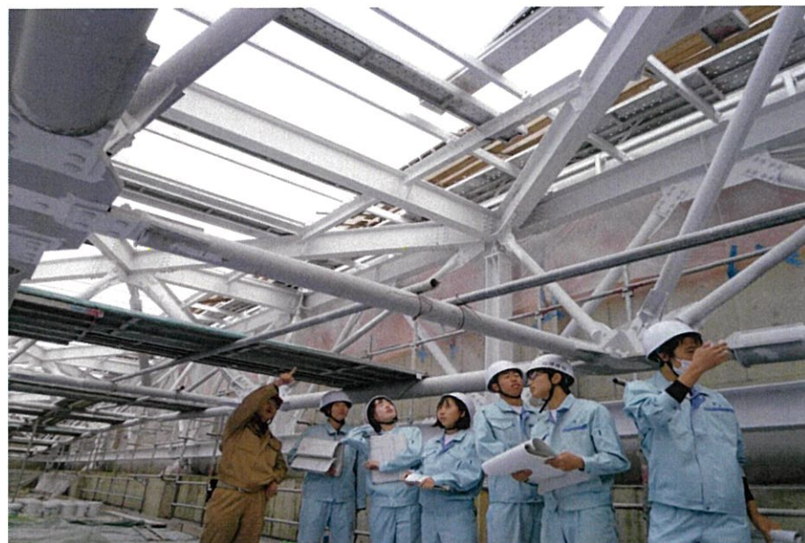
体育館屋根下に足を踏み入れると、無数の鋼材で屋根が組まれていた。
