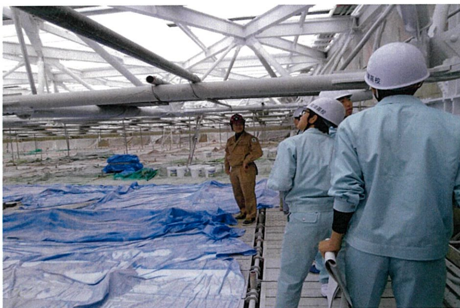
体育館屋根下を別角度から。使用した白い塗料は、結露防止効果を考慮して採用。
