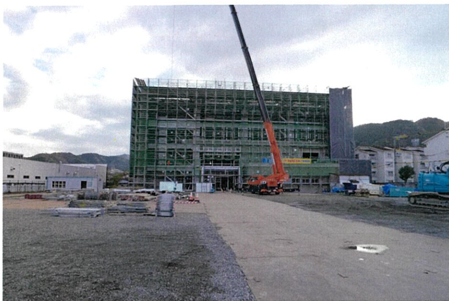
建物の外観。休憩時間で止まっていたが、オレンジの大型クレーンが稼働している。
