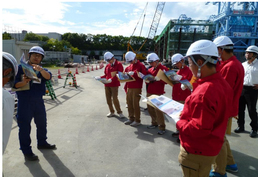
パンフレットを見て、ニューマチックケーソン工法の説明に耳を傾ける生徒達。
