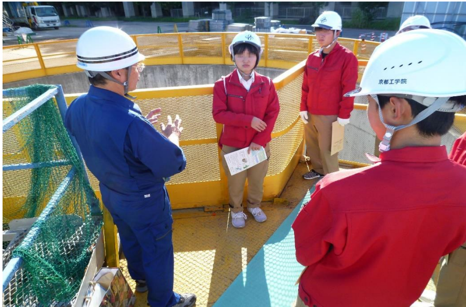
呑龍トンネルのシールドマシン発進立坑に来た。ポンプ場はトンネルと一体で計画された。
