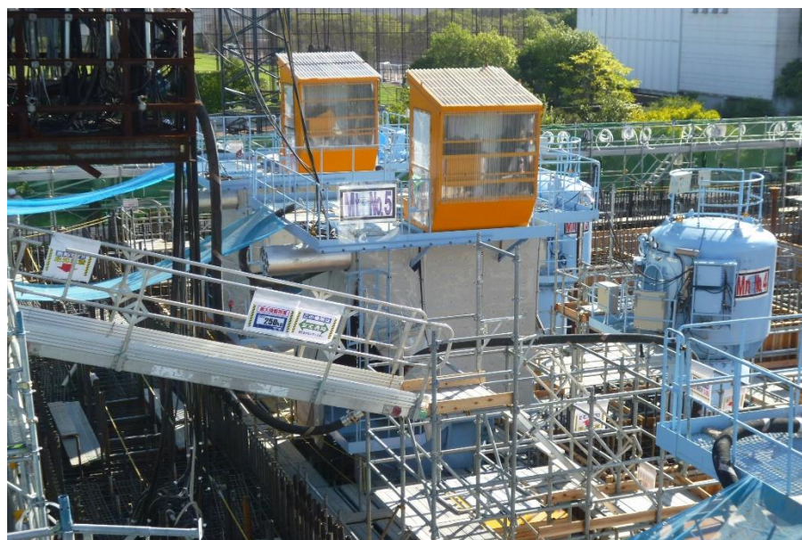
地下40mの作業室から土砂を運搬するマテリアルシャフト(黄色)と人が昇降するマンシャフト(青)
