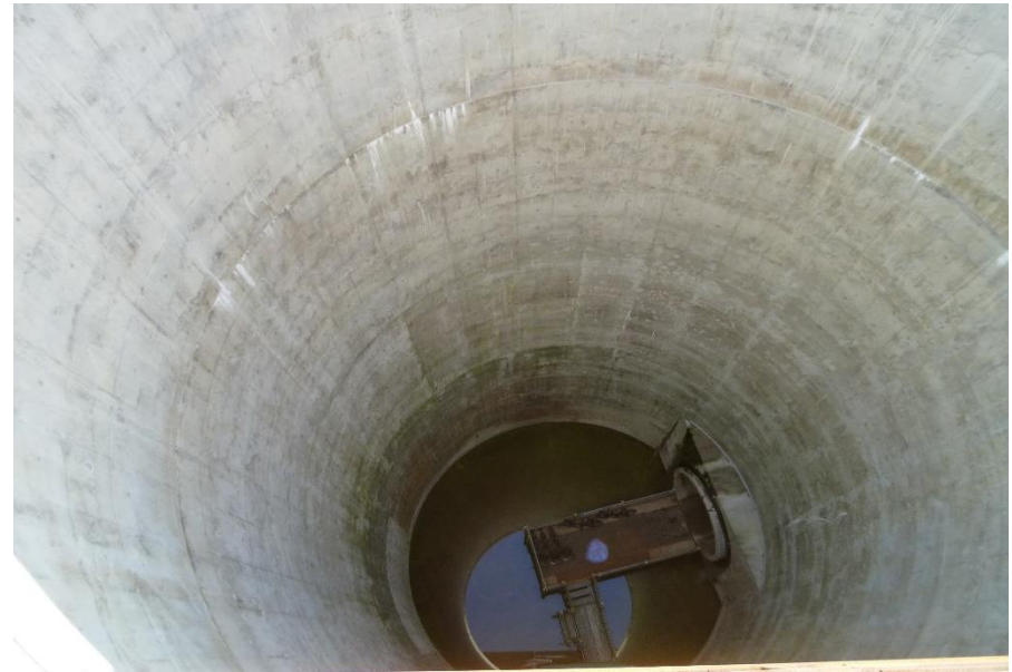
立坑内。すでにトンネルは供用されており、近くポンプ場へ通ずる地下水路も建設される。
