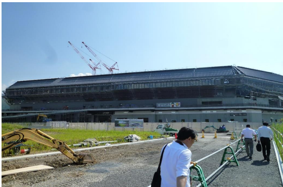
駅北口より京都スタジアムの全景。青空に向かって大型クレーンが二基そびえ立っている。
