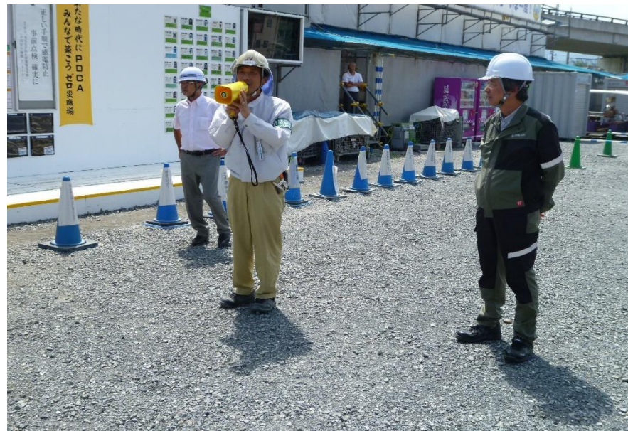
掲示板の前で再集合。現場の方からも未来の建築を担う若人たちにエール。
