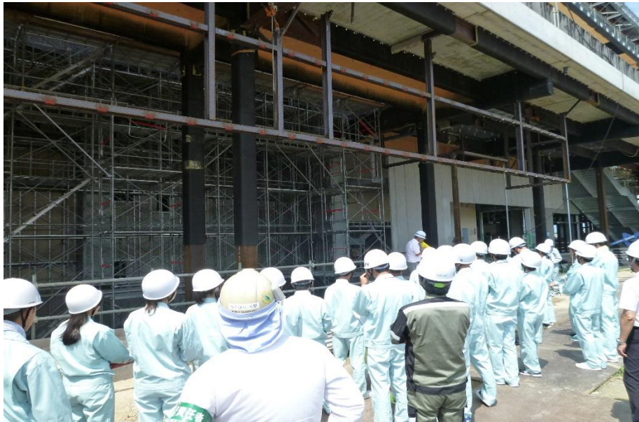
1Fクライミングウォール建設現場。足場が組まれ、工事が行われている様を実感。
