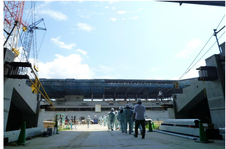
ピッチへ選手達より一足早く入場。資材や重機、クレーンが集まる工事拠点だ。
