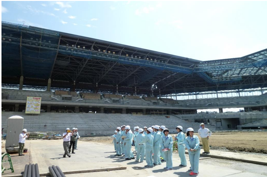
来春の開場に向けて、屋根や大型ビジョンの建設が進む。建築のダイナミズムを体感した一日。
