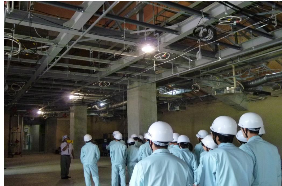
中へ踏み入ると、天井のダクト・配線がむき出しに。建設中だからこそ見れる光景。
