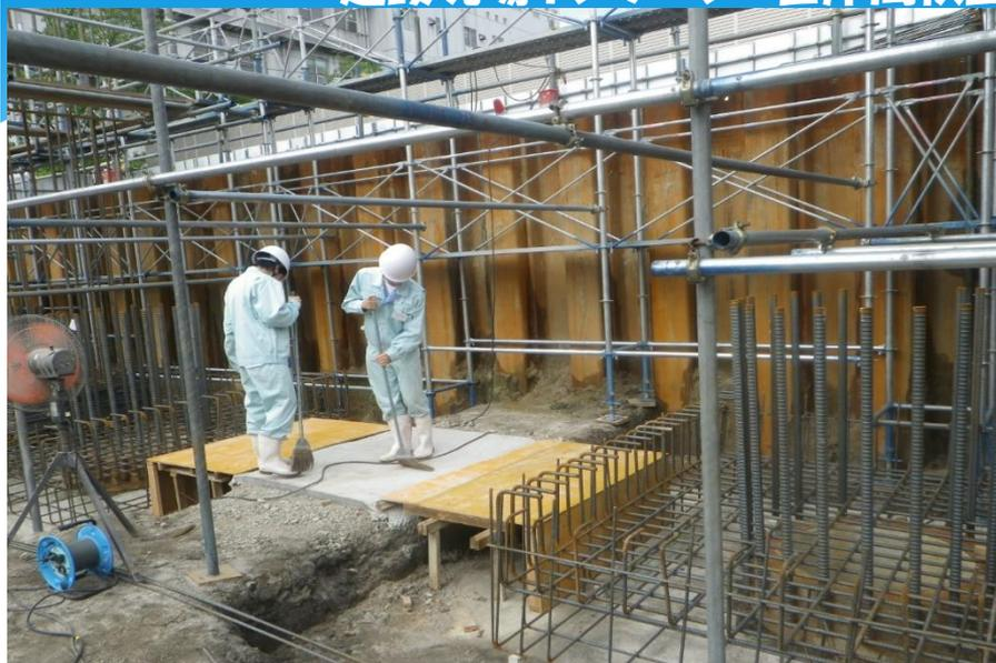
入念に墨出し前の清掃作業中。この後、鉄筋や型枠が組まれていく。
