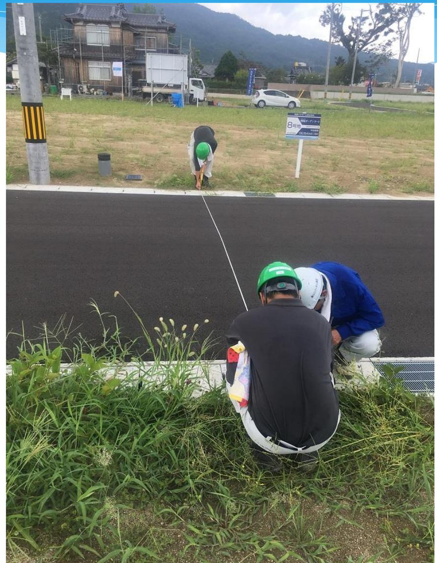
亀岡市内の住宅地で測量作業。メジャーで測る地道な作業を積み重ねる。
