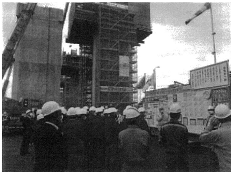
ピーエス三菱で橋脚工事が進む現場を見学
