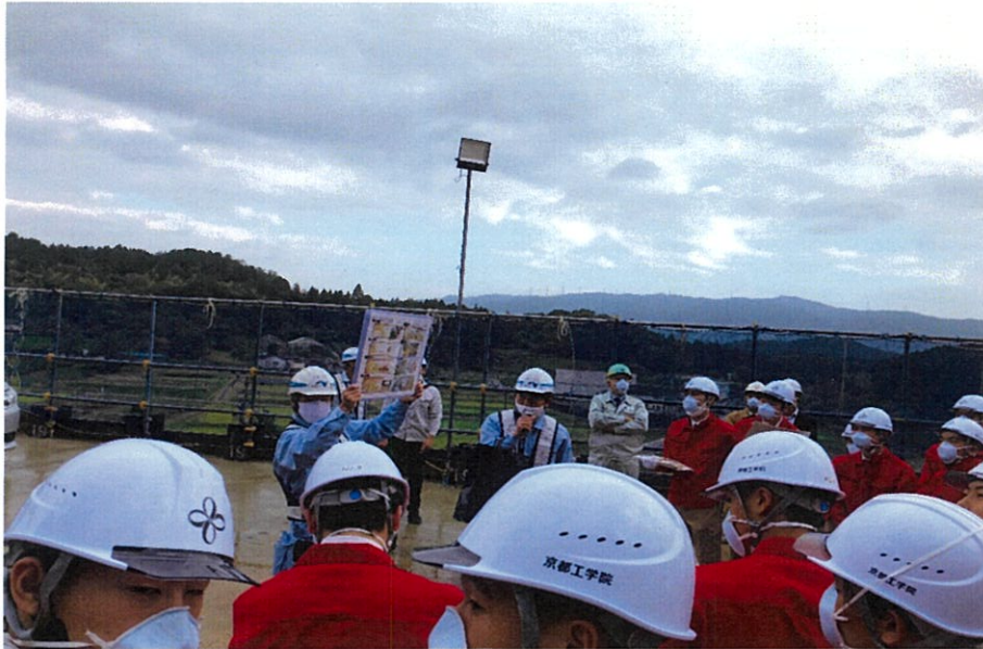
宇治田原トンネルの現場前で、掘削状況の説明中。専用マスクもしっかり装備。
