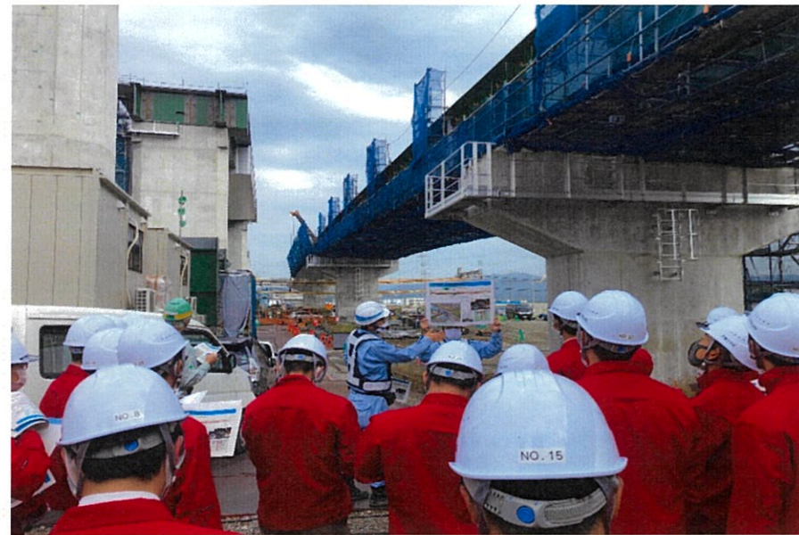
城陽高架橋で採用のプレキャストセグメント工法について、現地で解説。
