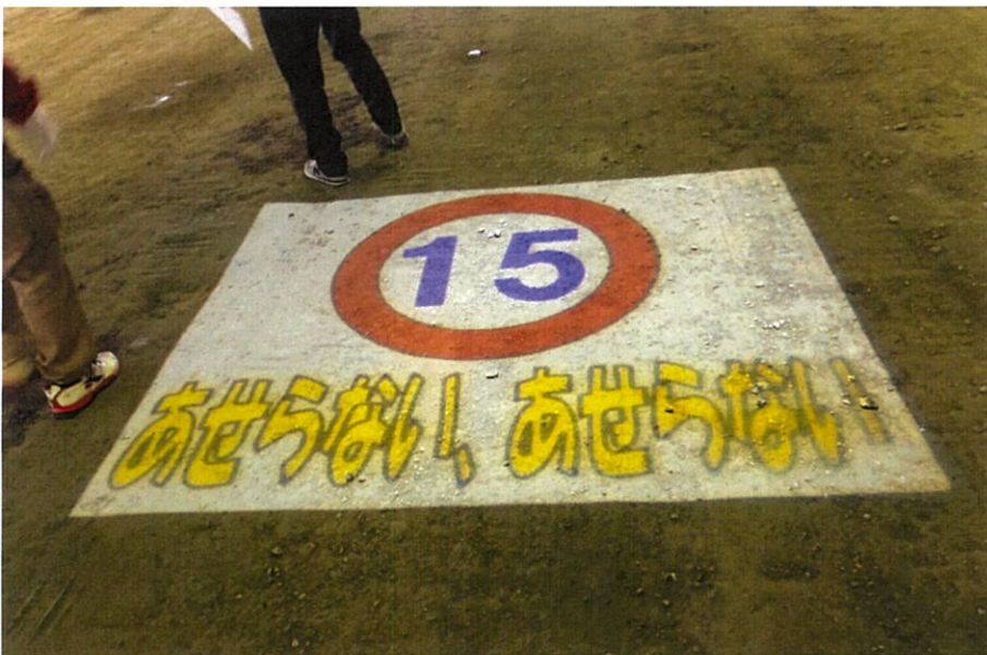
暗いトンネル内での視認性向上のため、標識はプロジェクション化している。
