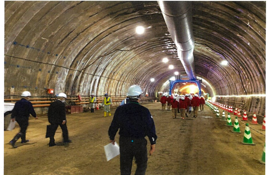
建設中の宇治田原トンネル内部を進んでいく生徒達。
