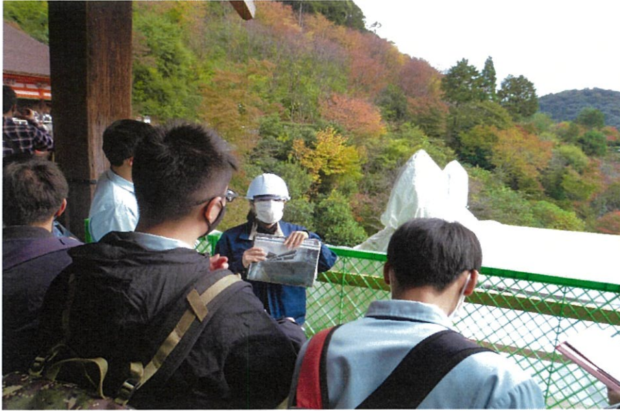
清水の舞台。修理作業が完了し、既に足場は取り払われ、白い防護布で覆われている。
