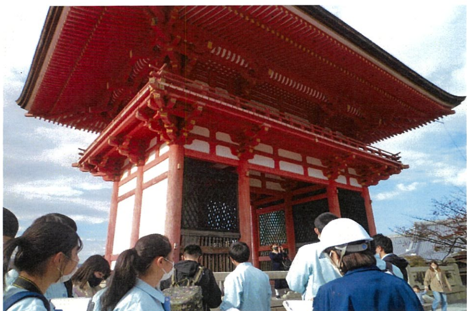
清水寺のシンボル、仁王門。檜皮葺きだが、柱は樺。明確に使い分けられている。
